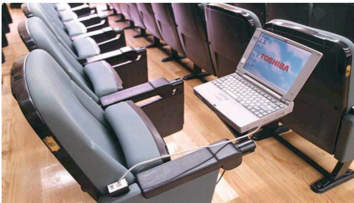
Portátil conectado en una toma de un aula
