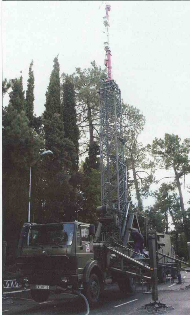
“Torre de MW” desplegada.
