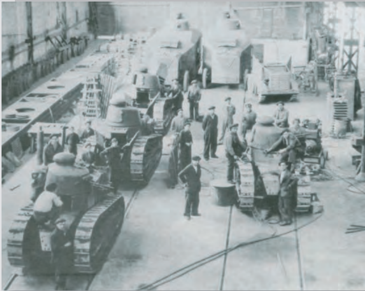
Carros Renault FT.17 sometidos a trabajos de mantenimiento en la Constructora Naval de Sestao. Al fondo, un tractor Landesa/Naval y los blindados artesanales. (Revista Española de Historia Militar)
