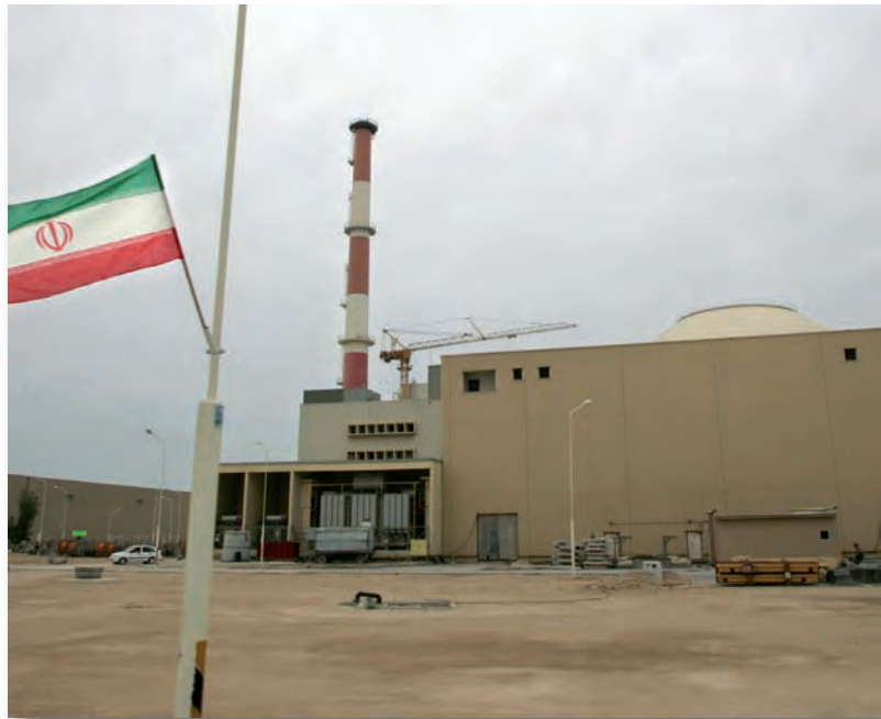
Proceso de construcción de un reactor nuclear iraní
