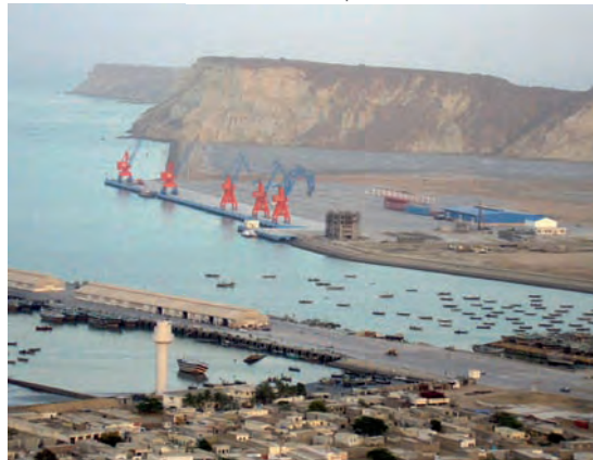
Instalaciones portuarias de Gwadar
