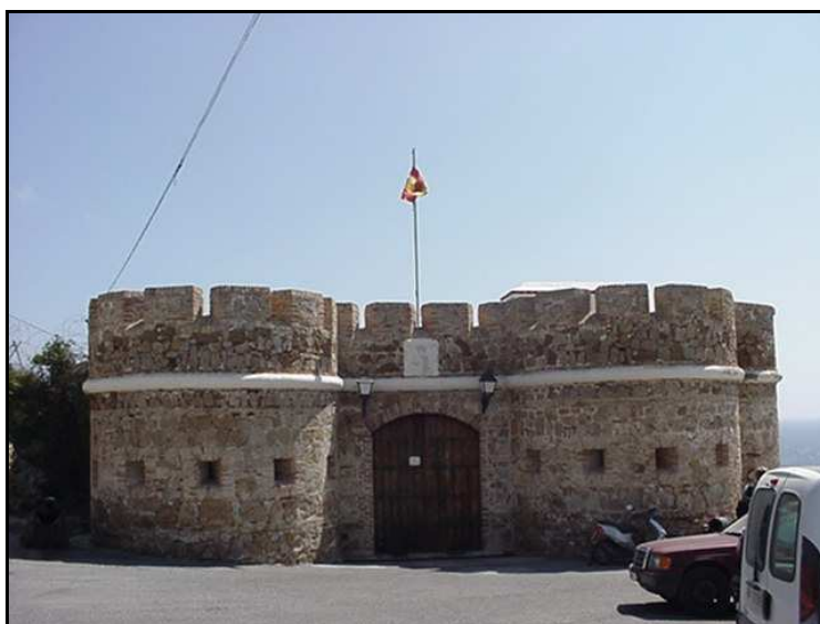
Figura 8: Estación sísmica de Banda Ancha CEU: Exterior del Castillo del Desnarigado.
