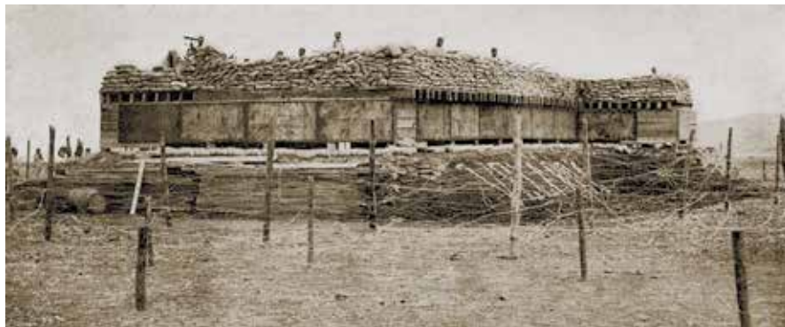
3.- Blocao protección tren minero
