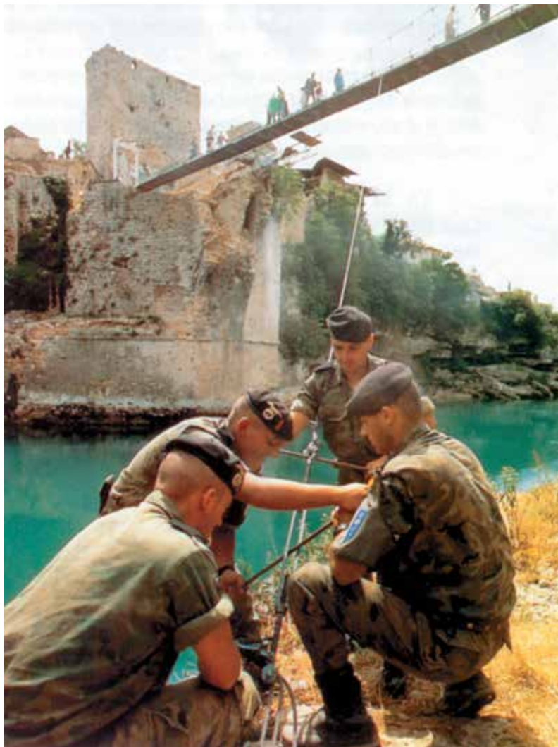
58.- Pasadera tendida en sustitución inicial del Puente Viejo de Móstar
