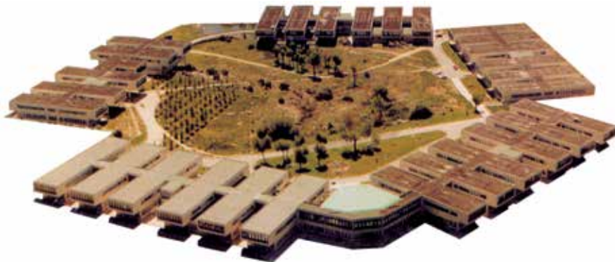
12.- Academia de Ingenieros en Hoyo de Manzanares (nuevos edificios)
