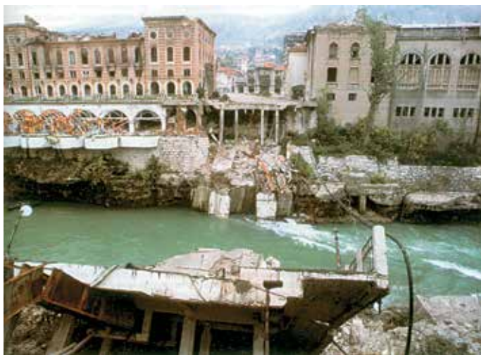
57.- Puente Viejo de Móstar destruido
