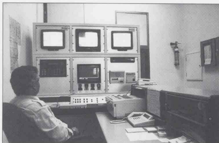
Fotografía 20. Desde el control de entrada también se vigila la Sala de Investigadores, a través de unos monitores en los que se puede seleccionar las imágenes que recogen diversas cámaras.
