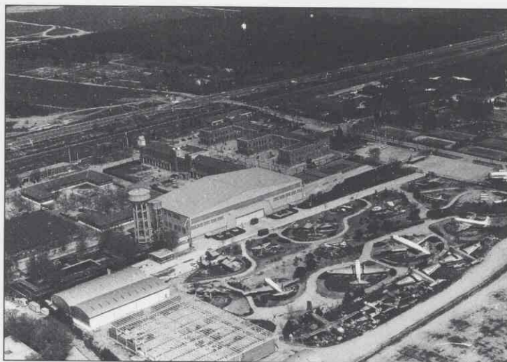
Fotografía 6. Construcción de nuevos hangares (1991).
