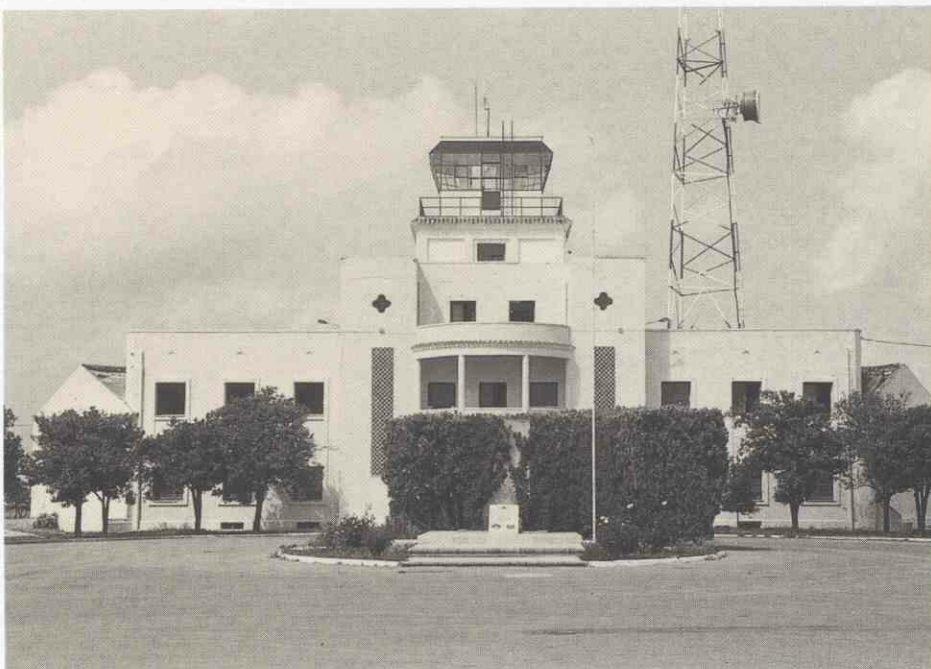
La Torre y Jefatura antiguas. Delante monolito y placas en Honor a los Caídos.
