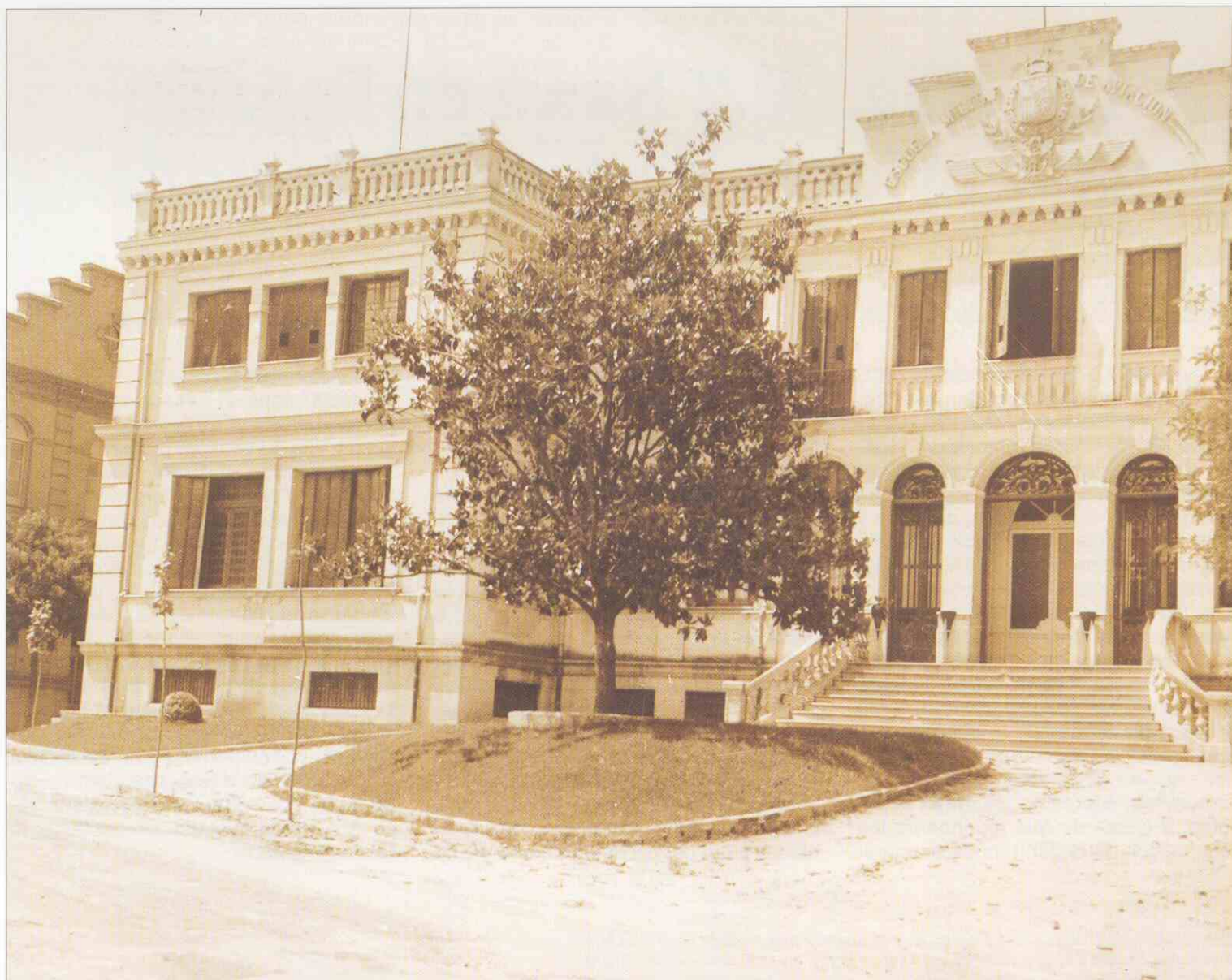
Fachada del pabellón con el frontis antiguo. Foto de 1955.
