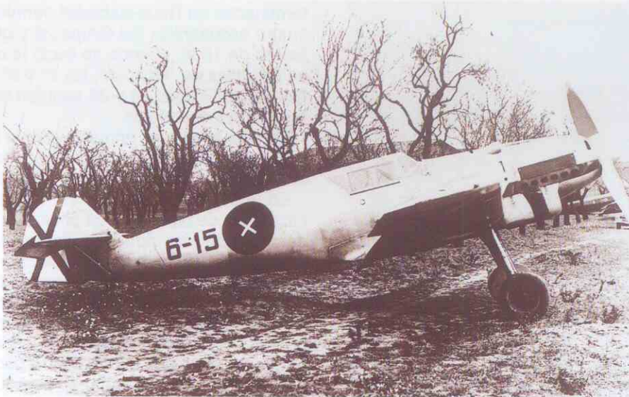
Caza monoplano Messerschmitt Bf-109B, con hélice de madera.
