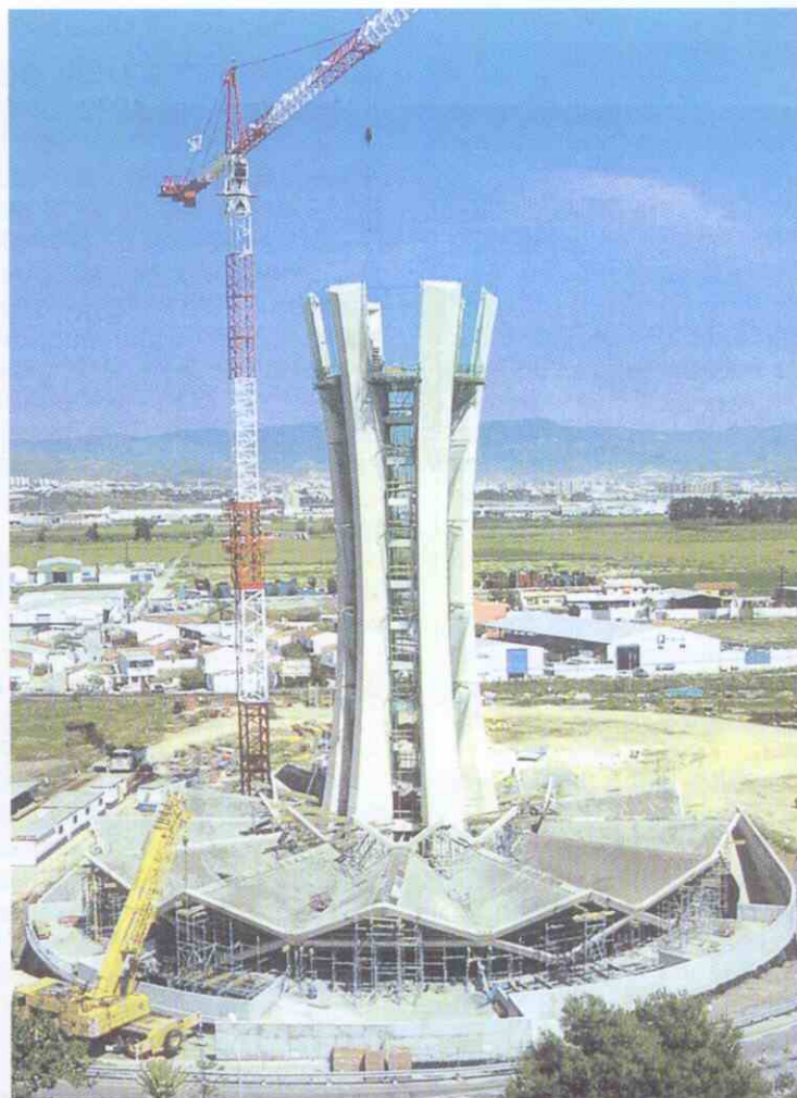
La nueva torre de control del Aeropuerto de Málaga, en fase de construcción; fue inaugurada el año 2002.
