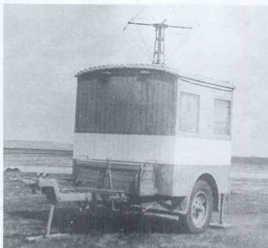
Movil portador de un equipo transmisor-receptor de frecuencia media (MDF), para control de operaciones en aeródromos. En el de Alcalá de Henares hubo un equipo de estas características, en las décadas de los años 40 y 50.
