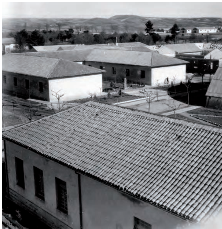
El acuartelamiento de tropa durante las obras que le dejaron en su configuración definitiva. Imagen tomada desde la torre de mando en dirección noroeste. Archivo Municipal de Burgos (Colección del sargento Primero Carro, cedidas por Francisco Briones).
