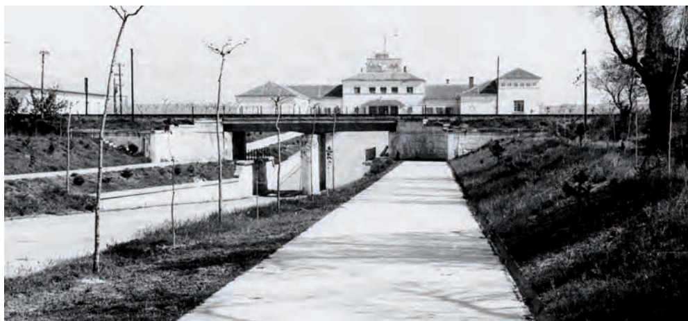
El paso inferior de la Calle A bajo la vía férrea Madrid-Hendaya quedó concluido a finales de 1942. Archivo Municipal de Burgos (Colección del sargento Primero Carrero, cedidas por Francisco Briones).
