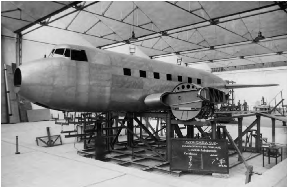
Repetición del ensayo de flexión del fuselaje el 26 de octubre de 1950 tras la introducción de unos refuerzos locales.
