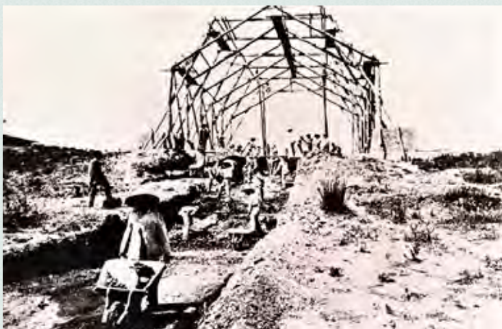
Construcción del hangar para el dirigible España en Guadalajara
