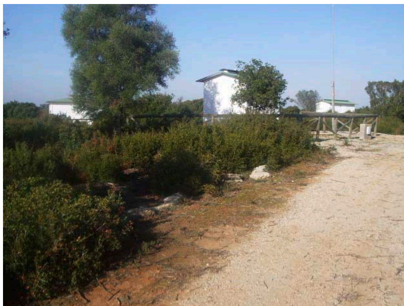
Figura 1: Vista exterior del Observatorio Geomagnético localizado en el “Cortijo Garrapilos”
