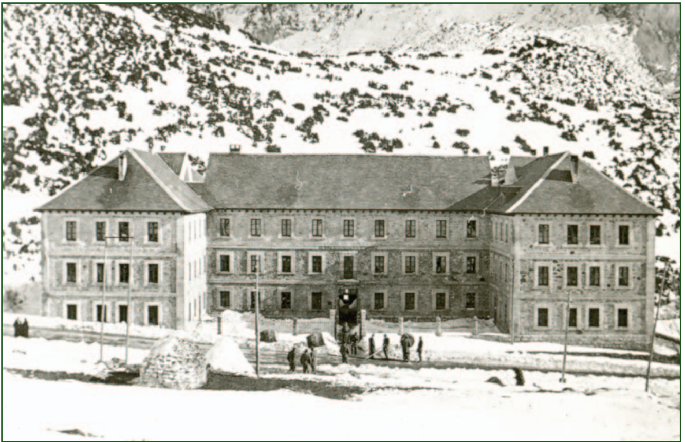
1955. Acuartelamiento Coll de Ladrones
