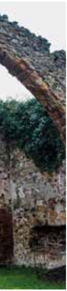
Interior de la iglesia de San Pedro Abanto (imagen del autor).
