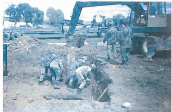
La compañía de zapadores construyendo el embarcadero de vehículos del CASR (Venta Carpinteros) en febrero de 1996.
