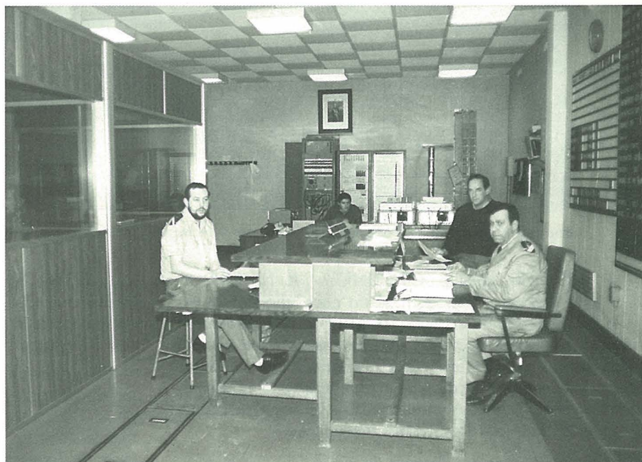
Una de las salas de equipos. «LA CARREIRA».
