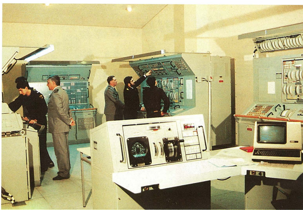
Edificio de Simuladores. Cámara de control de las fragatas.
