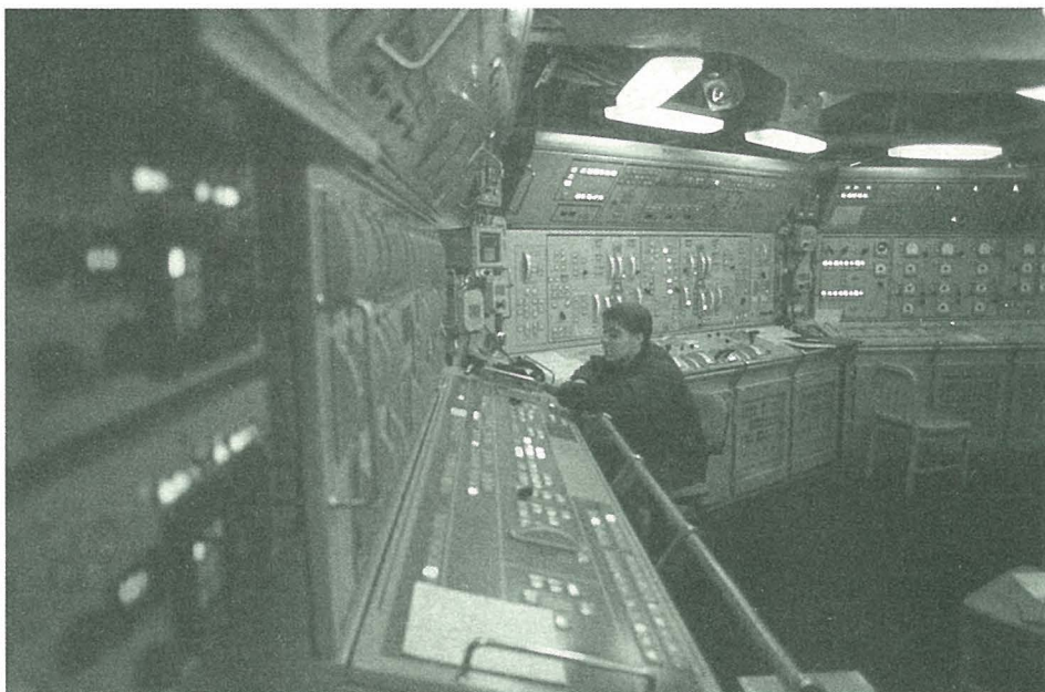
Equipos complejos sustituyen al hombre.
