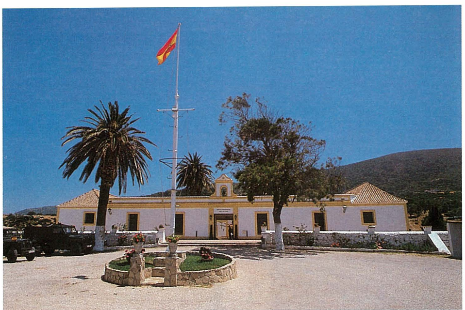
Vista general del Acuartelamiento.
