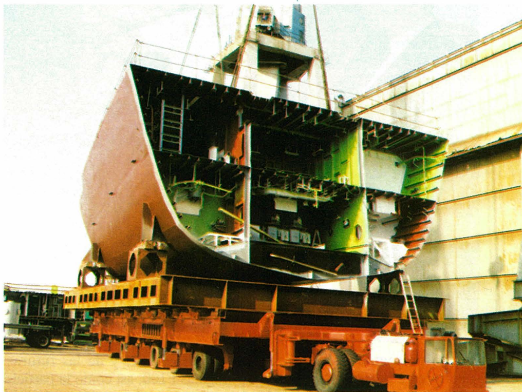
Traslado de un bloque mediante una plataforma móvil hidráulica de 250 Tns. de capacidad máxima a la grada. En este bloque, construido en base a prearmamento avanzado, se aprecian los equipos, tuberías, conductos, aparatos de alumbrado, estibas, canalizaciones electricas, etc., instaladas en el mismo.
