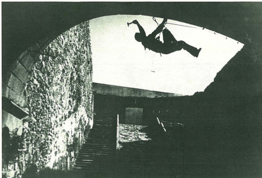
Entrenamiento sobre el puente de Fuente Longa.
