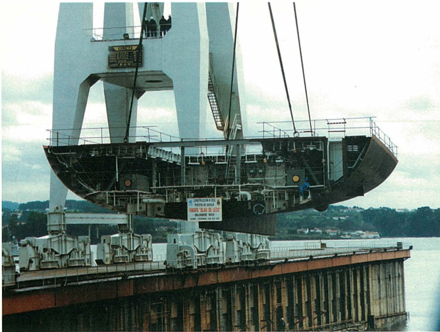
Concluida la botadura, se procedió a la colocación de una sección de la quilla de la Blas de Lezo futura F-103.
