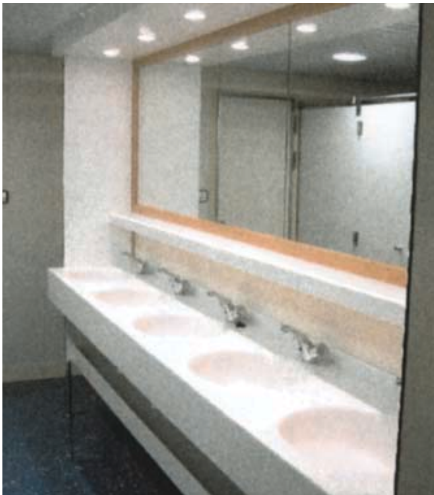
Lavabos después de las obras.
