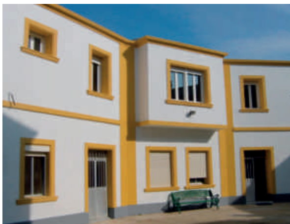
Patio interno de la Comandancia Militar de Huelva
