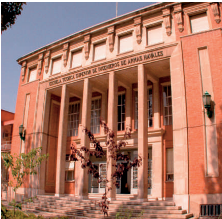
Fachada Principal de la E.T.S.I.A.N. sede del GIMO.
