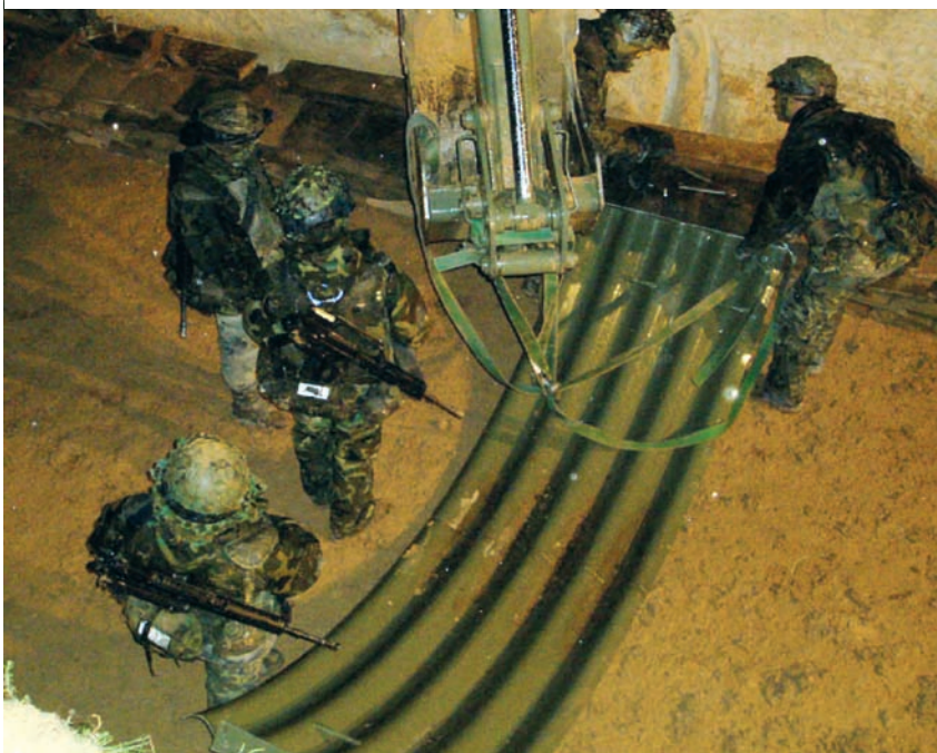
Equipos de zapadores a pleno rendimiento. momento de la construcción de "la madriguera"
