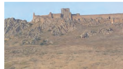
Arriba: Vista general de la situación del Castillo de Mora.
