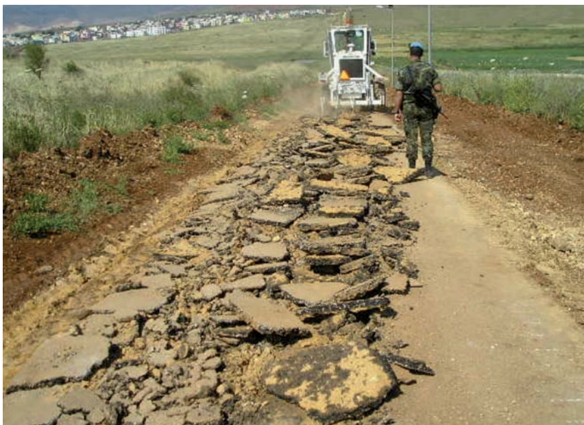
Trabajos de reconstrucción de la carretera SD-1
