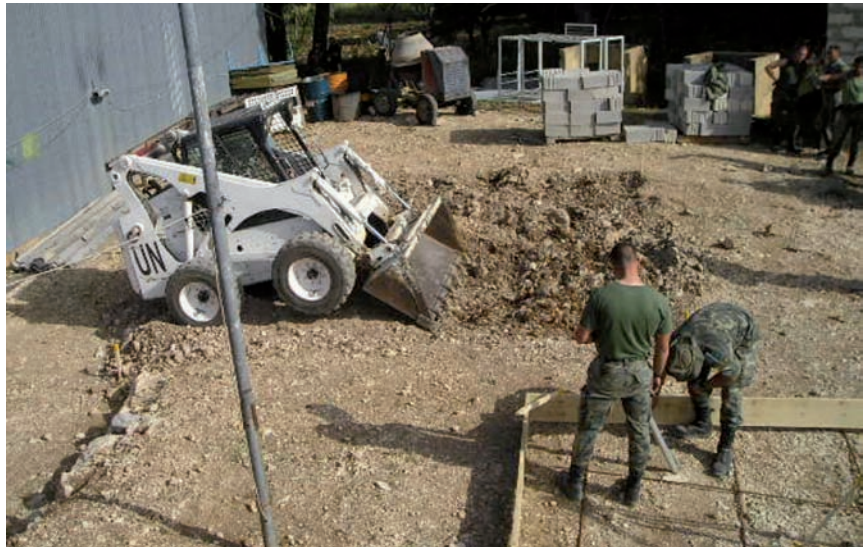
La Sección de Apoyo realizando trabajos de fortificación
