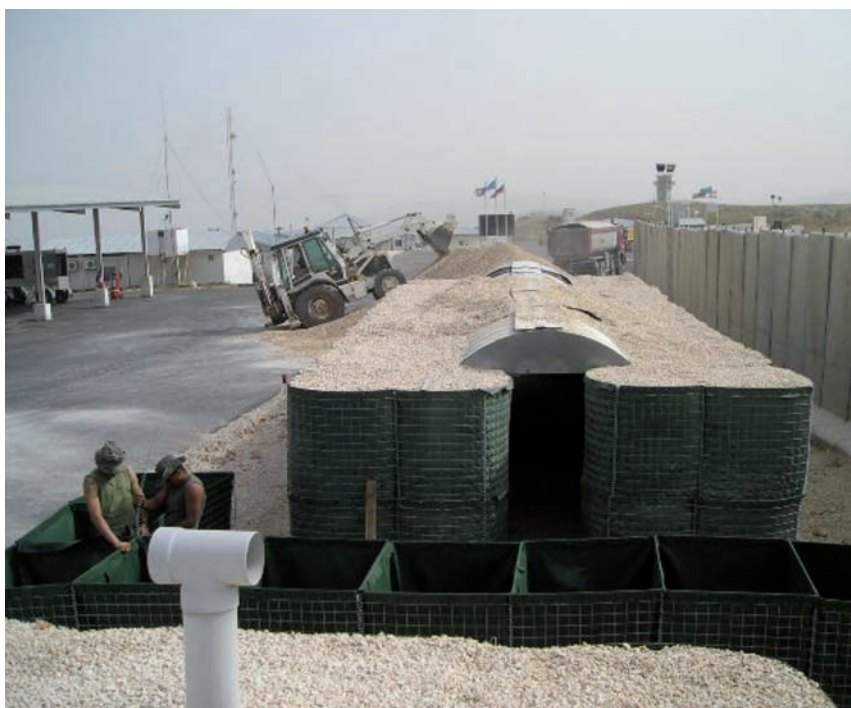
Construcción de refugios
