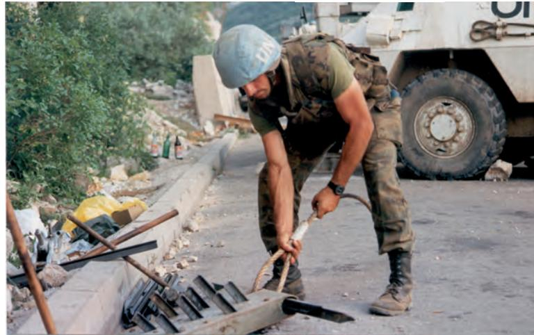
Teniente de zapadores comprobando el anclaje de un equipo de fuerza Tractel durante las operaciones de rescate del puente de Dreznica
