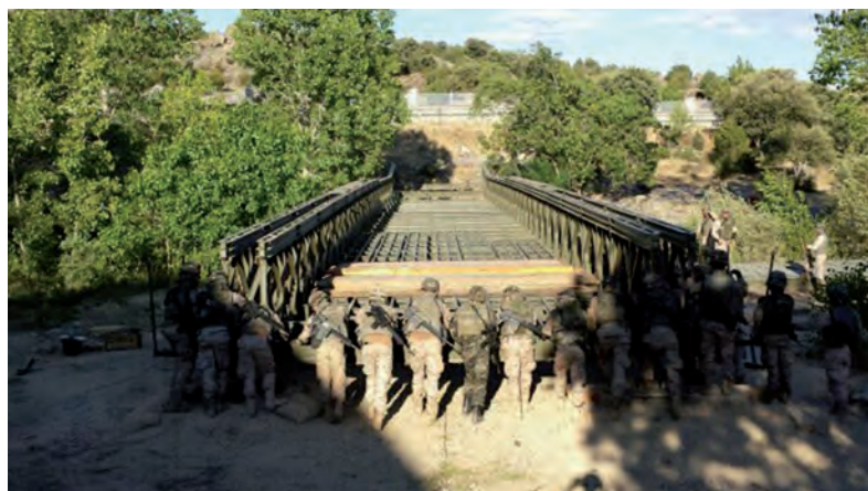
El personal de zapadores lanza el puente a mano durante las prácticas de medios de paso
