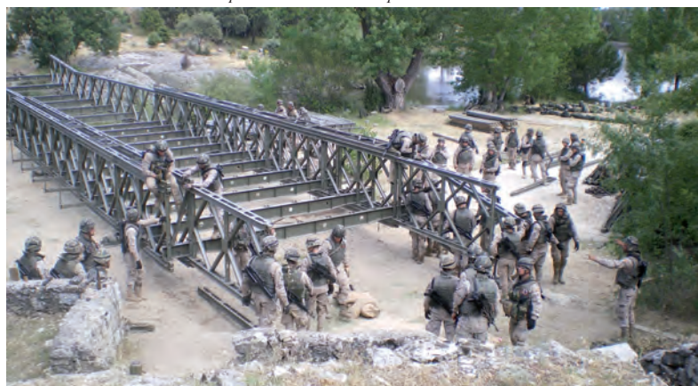
Un momento del montaje del puente
