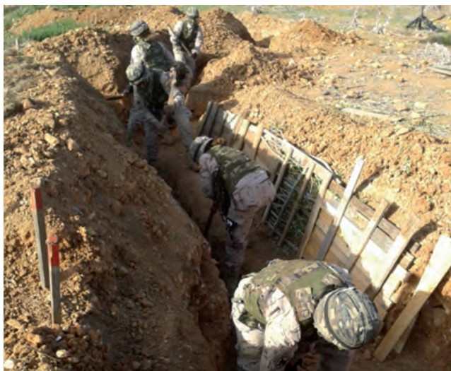
Un momento de los trabajos de fortificación
