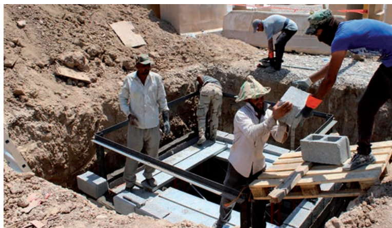
Construcción de una nueva fosa séptica
