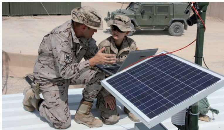
Comprobando el funcionamiento de la instalación
