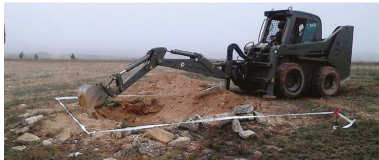
Reparando un hoyo en la pista
