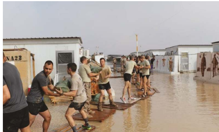
Formando diques de contención con sacos terreros
