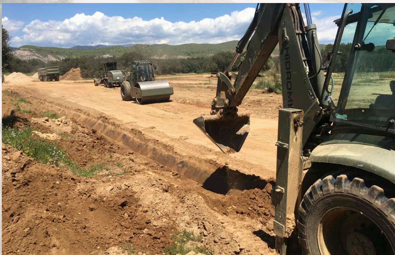
La Sección ORTE a pleno rendimiento en la construcción de la pista de conducción (foto: BZPAC)
