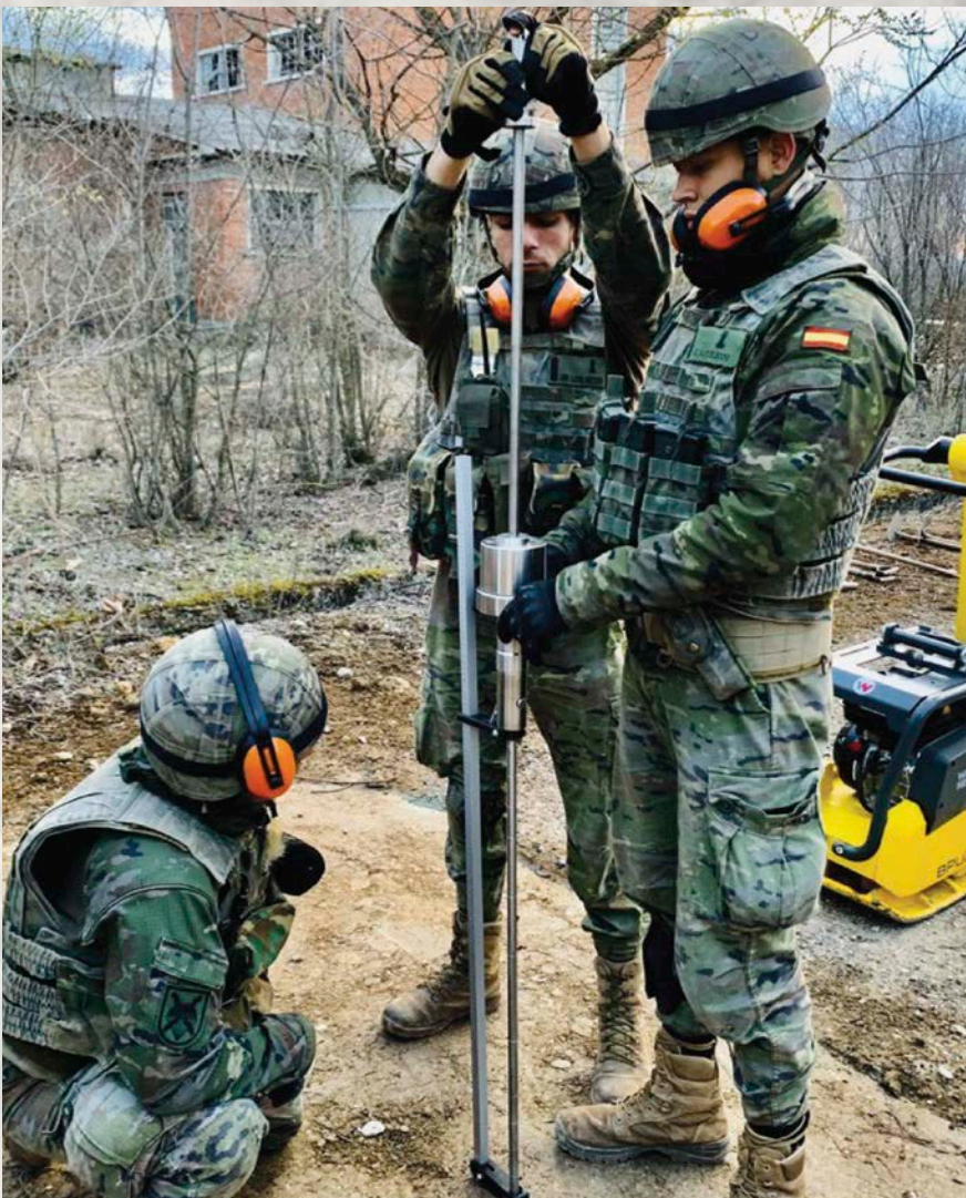
Equipo LRUA preparando el terreno (foto BZPAC)
