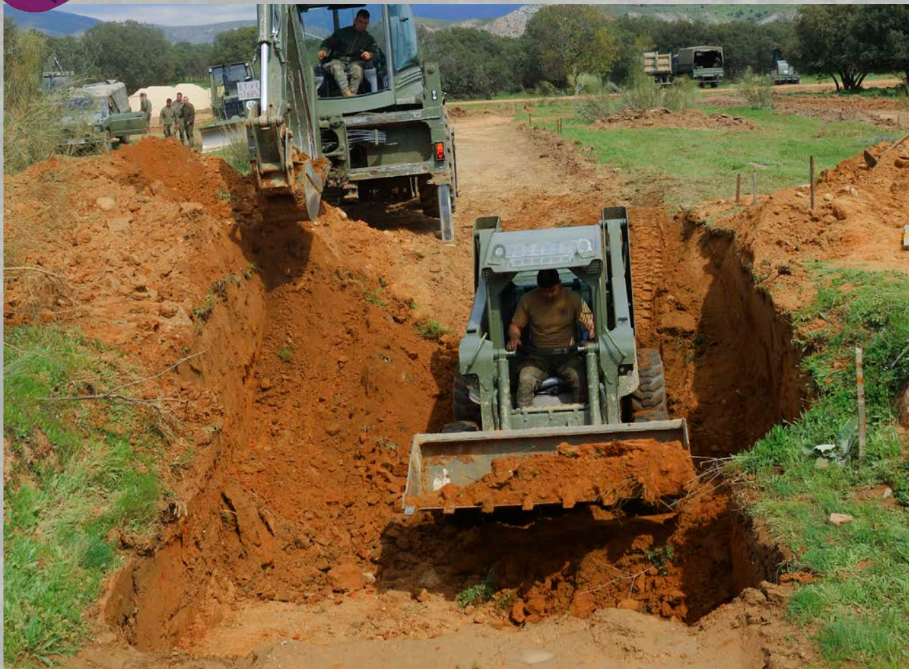
Trabajos de construcción de la pista de conducción (foto BZPAC)
