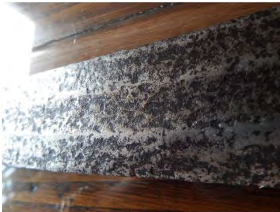
Figura 49. Vistas de la espada. (Fuente: el autor)
