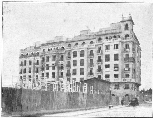
Fot. 17.—Construcción de cuatro casas del tipo C en la calle de Martín de los Heros. Estado de las obras en 1.º de julio de 1929.
