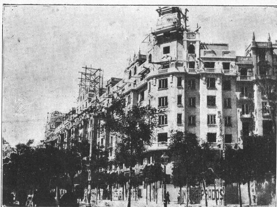
Fot. 12.—Construcción de tres casas del tipo A y cinco del tipo B en la calle de Santa Engracia. Esquina de la calle de María de Guzmán. Estado de las obras en 1.º de julio de 1929.
