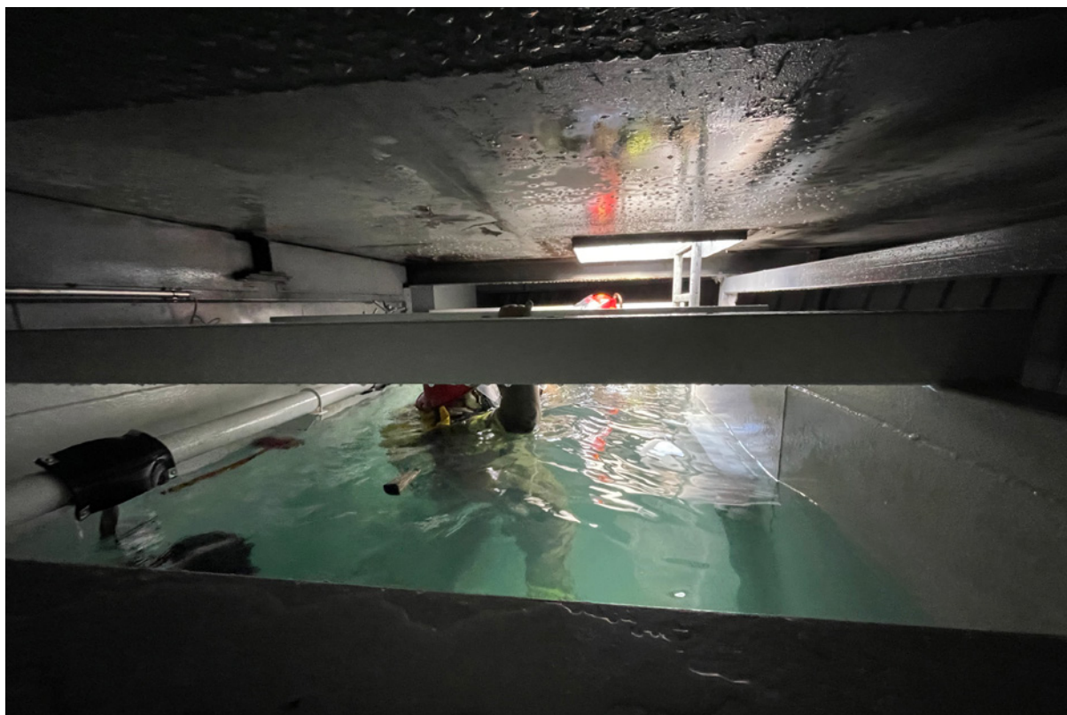
Control de averías
