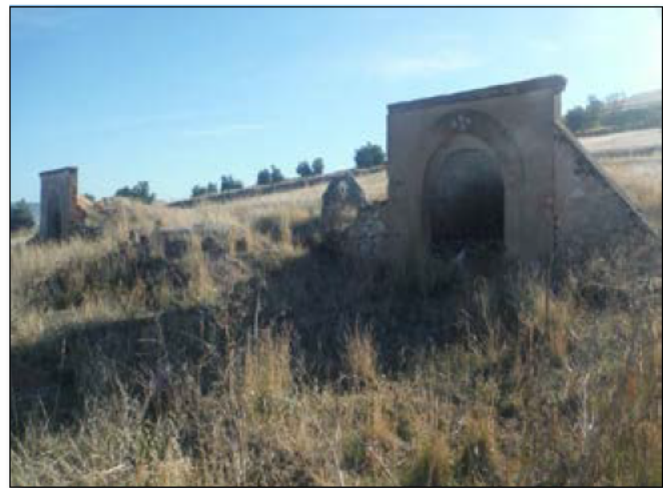
Entradas al polvorín Aeródromo Valdepeñas (Fotografía de los autores)
