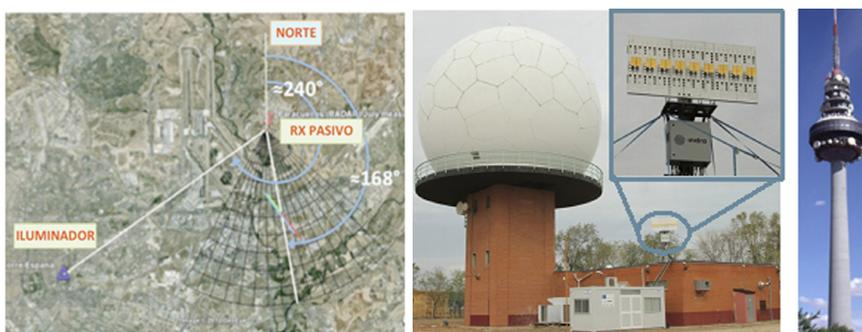
Fig. 4. De izda. a dcha.: escenario de pruebas definido para el demostrador APIS, emplazamiento del receptor radar (Paracuellos I), iluminador de oportunidad (Torrespaña).
