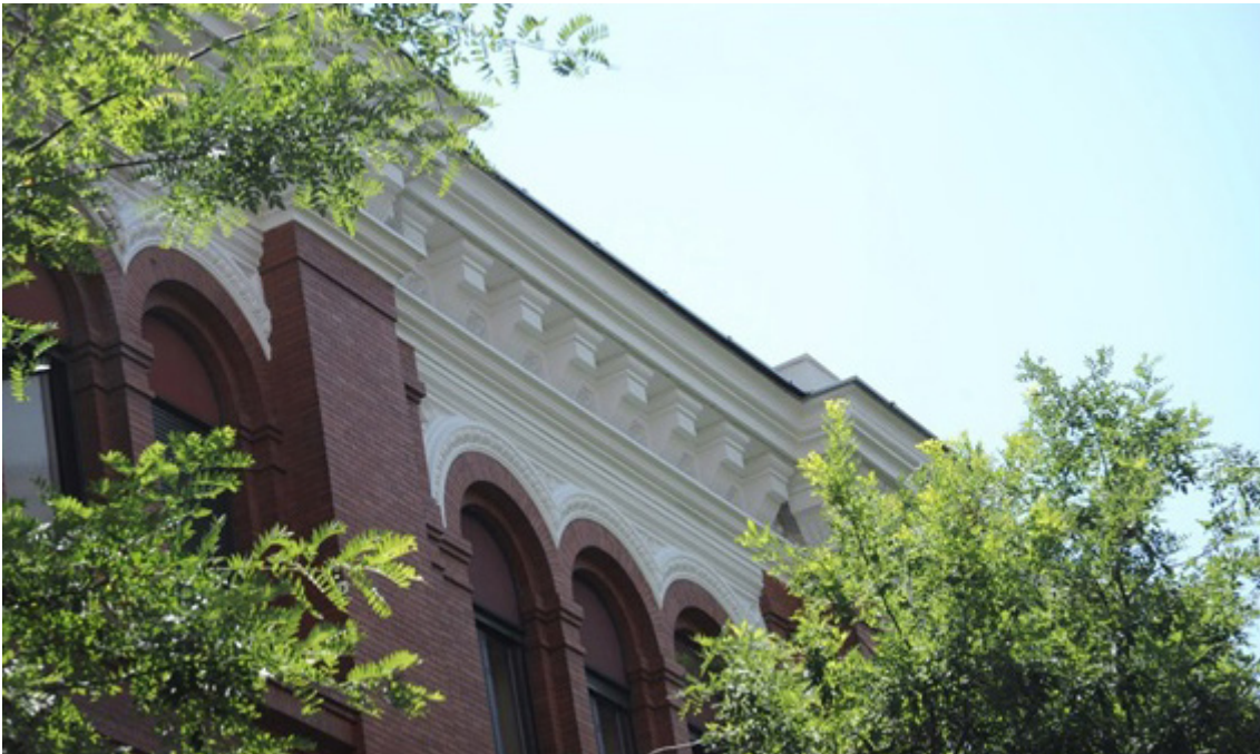
Saneamiento de cornisas, limpieza y pintado de la fachada
