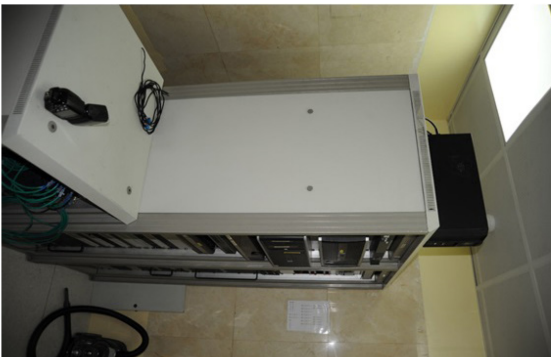
Reforma y acondicionamiento de cuarto de audiovisuales para traslado de equipos y servidores
