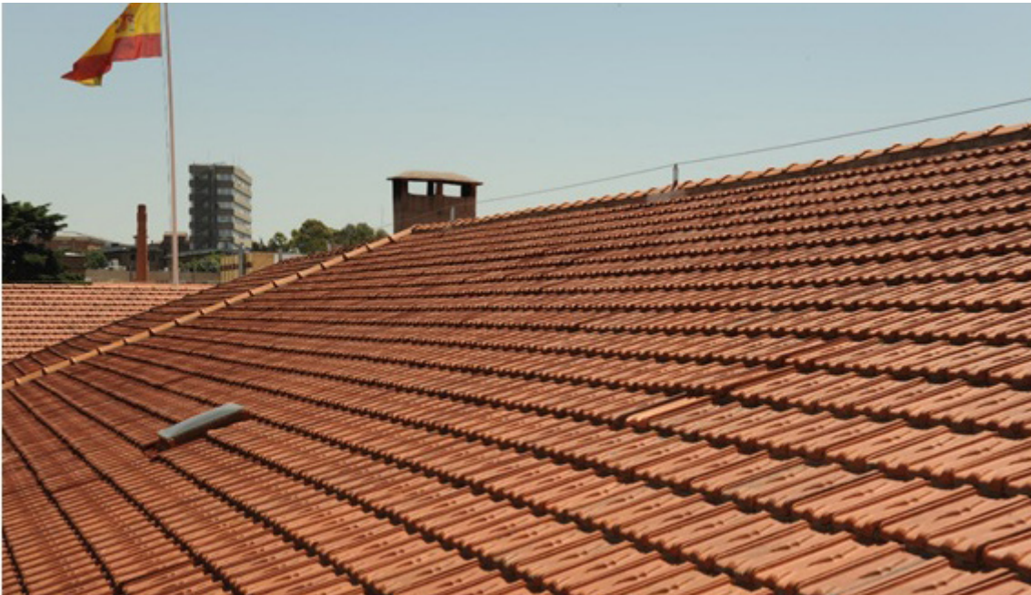
Instalación de líneas de vida en los tejados de los edificios del Centro
