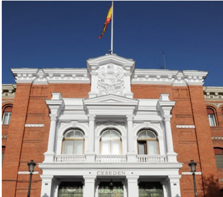
Remodelación de los ventanales con terraza de la fachada principal del edificio
