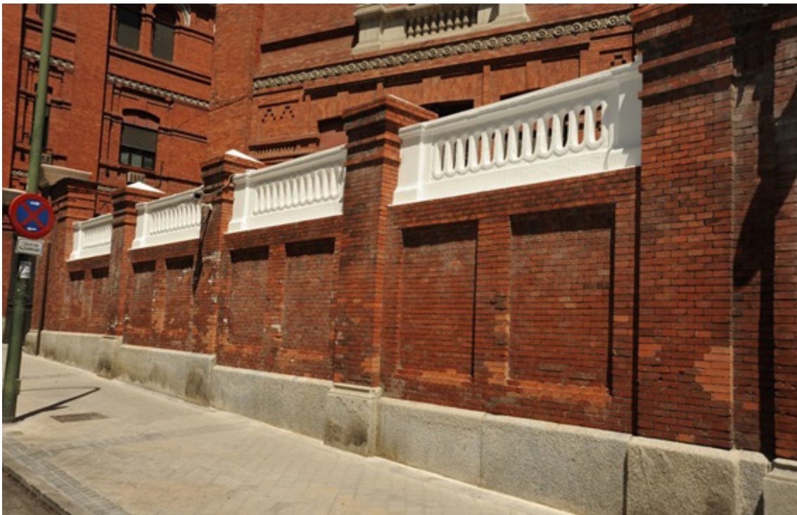
Reconstrucción de balastradas en la calle Bretón de los Herreros
