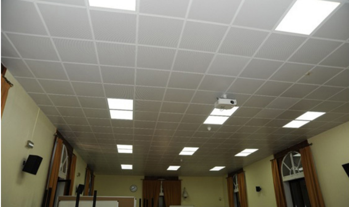
Instalación de techo técnico nuevo en el aula n° 3
