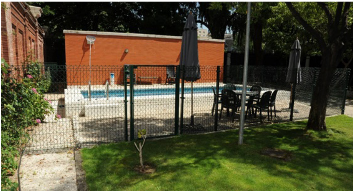
Instalación de vallado de cerramiento de seguridad en la piscina de los jardines del pabellón de carga del DICESEDEN
