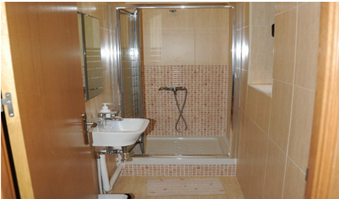
Transformación de un cuarto de la 2º planta del edificio JAS en vestuario VIP, mediante la instalación de ducha y lavabo
