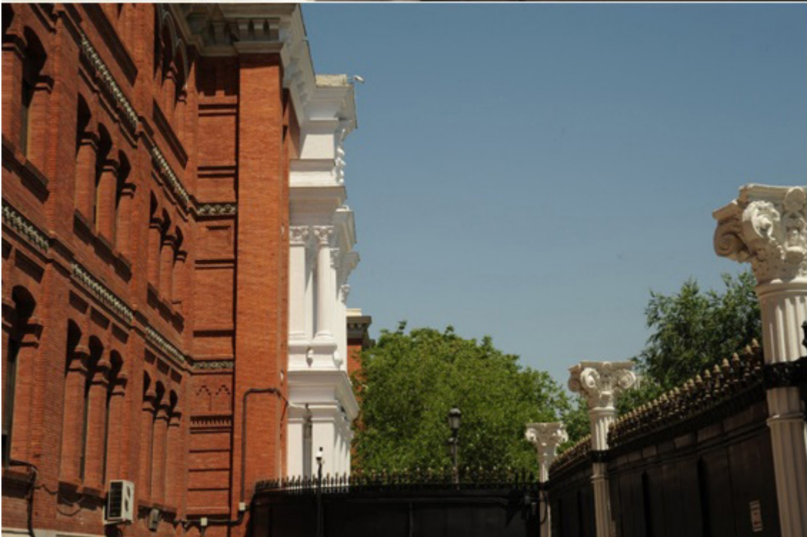
Reconstrucción y pintado de las columnas de la valla de cerramiento en el paseo de la Castellana
