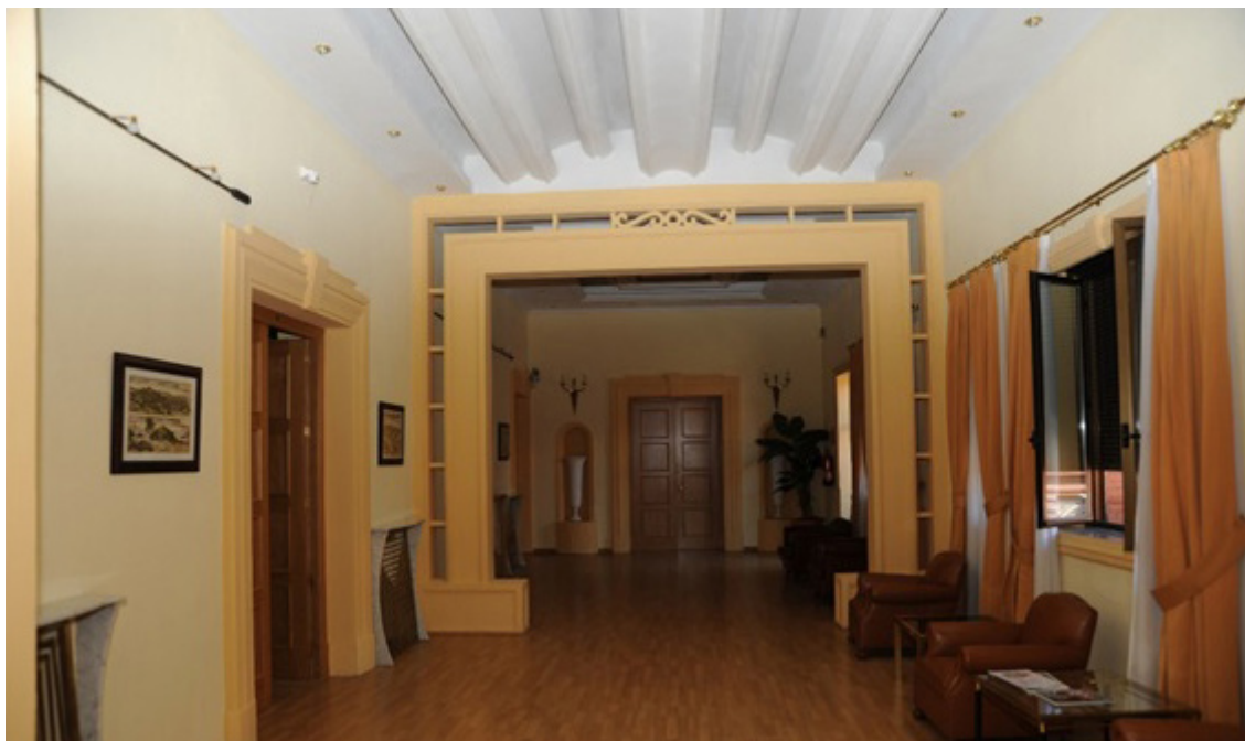
Saneamiento y pintado del pasillo del CCDC
