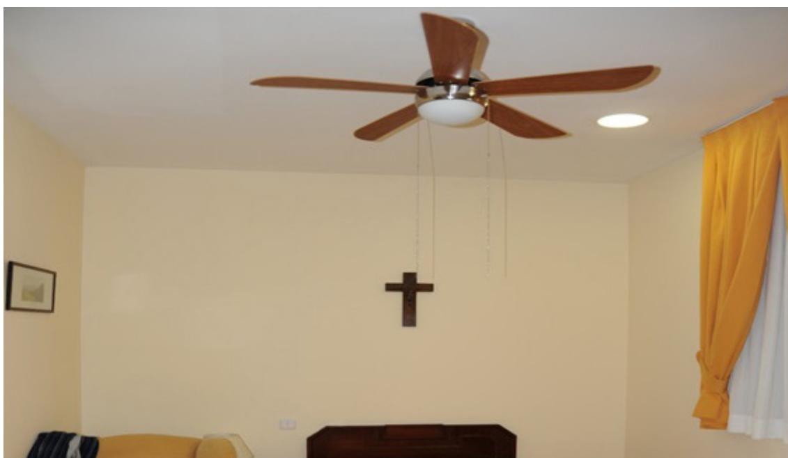
Instalación de ventiladores
