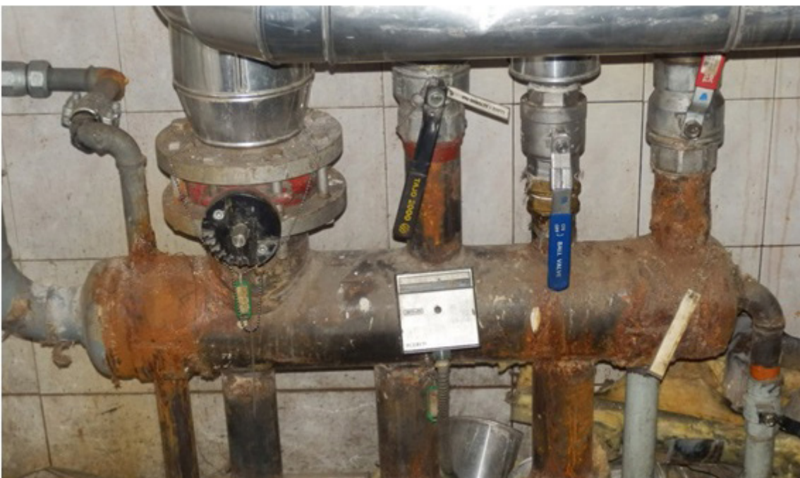
Sustitución del colector de retorno de la sala de calderas
