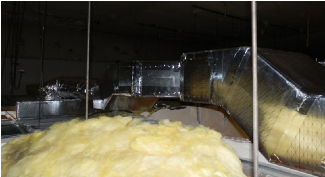
Mejoras y sustitución de los conductos del aire acondicionado del ala este de la 2ª planta del edificio de la JAS
