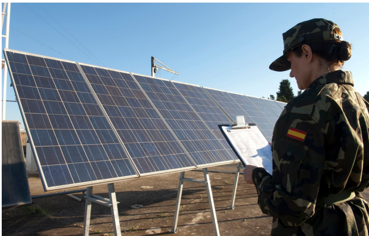
El uso de energías limpias como la solar es cada día más habitual en las instalaciones del Ministerio de Defensa.
