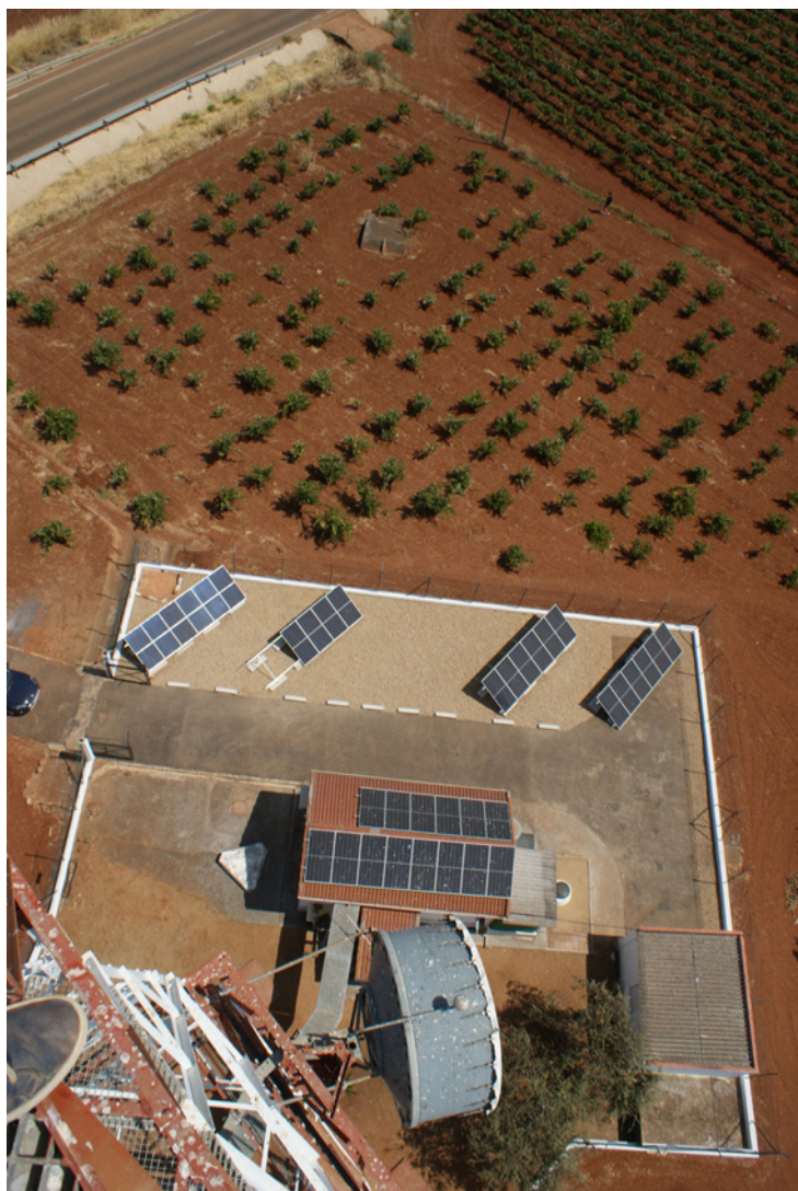
Instalación de placas fotovoltaicas en el RCT «ALMENDRALEJO» (BADAJOZ), siendo el primer centro de comunicaciones de las FAS alimentado mediante este sistema.
