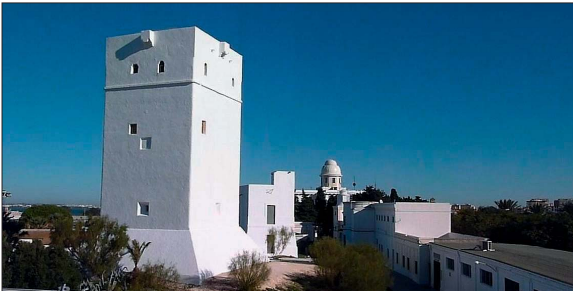
Figura 5.5: Vista de Torre Alta desde el Sur.
