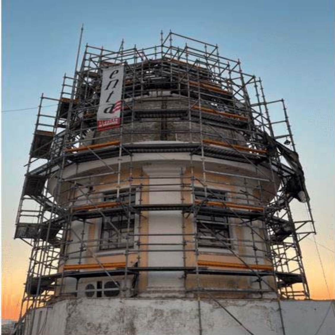
Figura 3.12: Imagen de la cúpula del Observatorio durante las obras de restauración.
