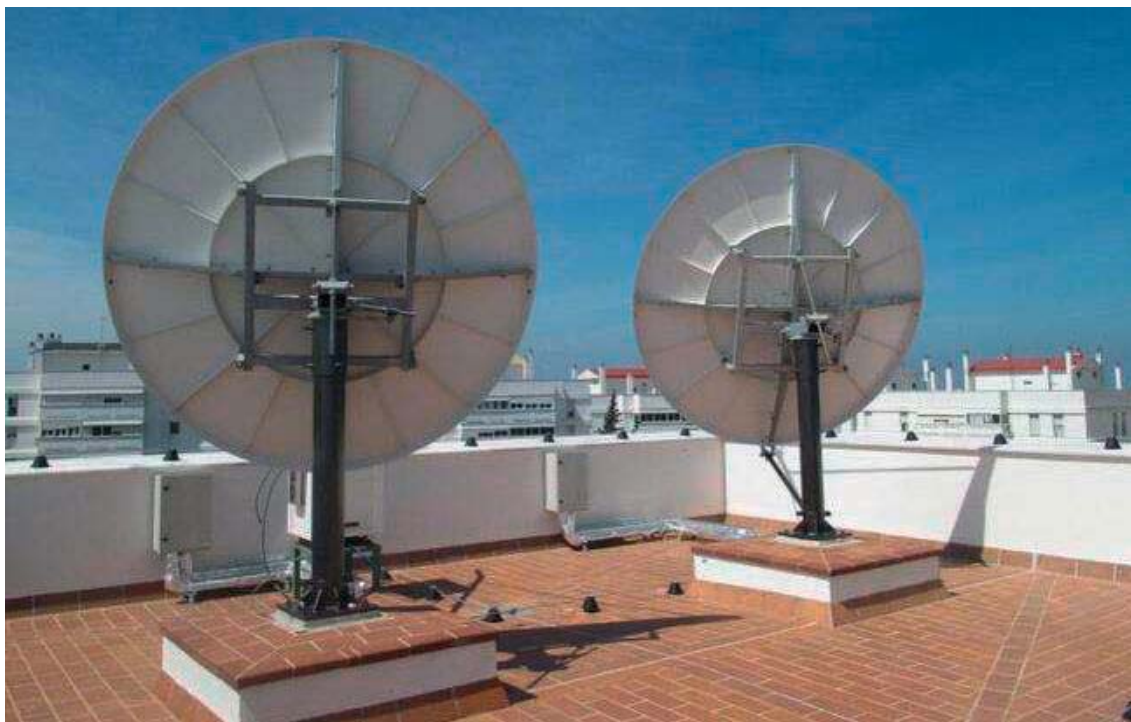
Figura 4.7: Antenas de la estación 1 (izqda.) y estación 2 (dcha.) del sistema TWSTFT, en la azotea del laboratorio.
