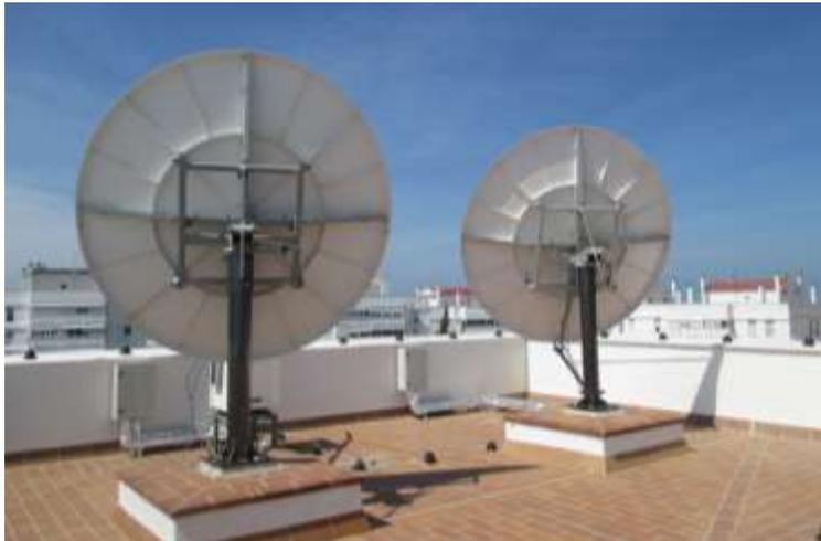
Figura 4.6: Antenas de la estación 1 (izqda.) y estación 2 (dcha.) del sistema TWSTFT, en la azotea del laboratorio.
