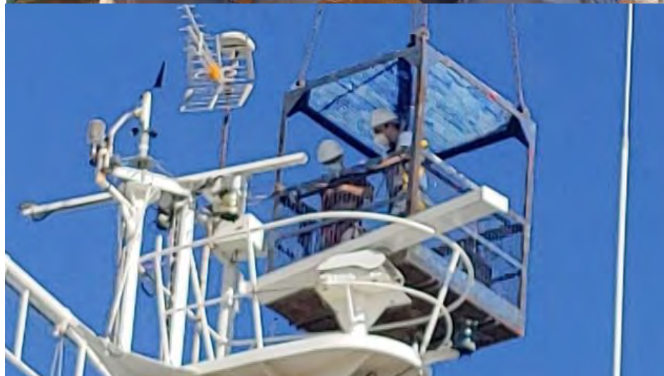
Trabajos de instalación del EM2040 en el BH Malaspina y Seapath 380 en el BH Tofiño
