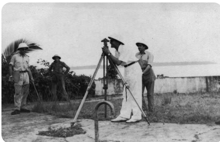
Trabajos en Guinea (colección Arbolí)
