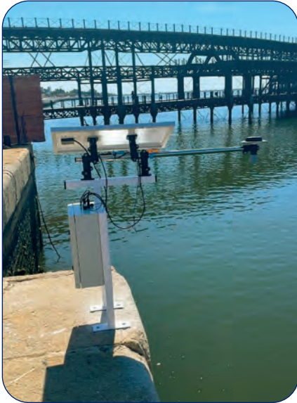
Mareógrafo DeepWave instalado en el puerto de Huelva
