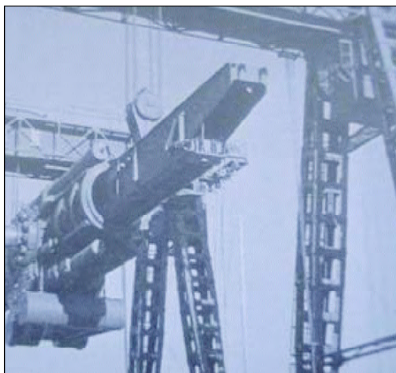
Montaje de la cuna con el órgano elástico
