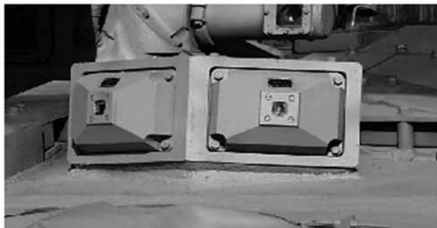
Detectores de alerta láser situados sobre el techo de la torre.
