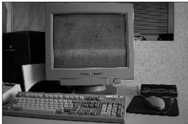
Puesto de Programación y Control.
