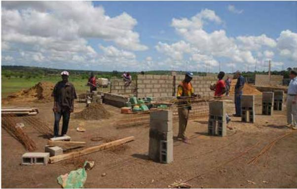
Figura 5.—Construcción de un edificio con tres aulas y porche y un bloque sanitario con tres letrinas en un colegio de Chetou-Dombila (Kati).
