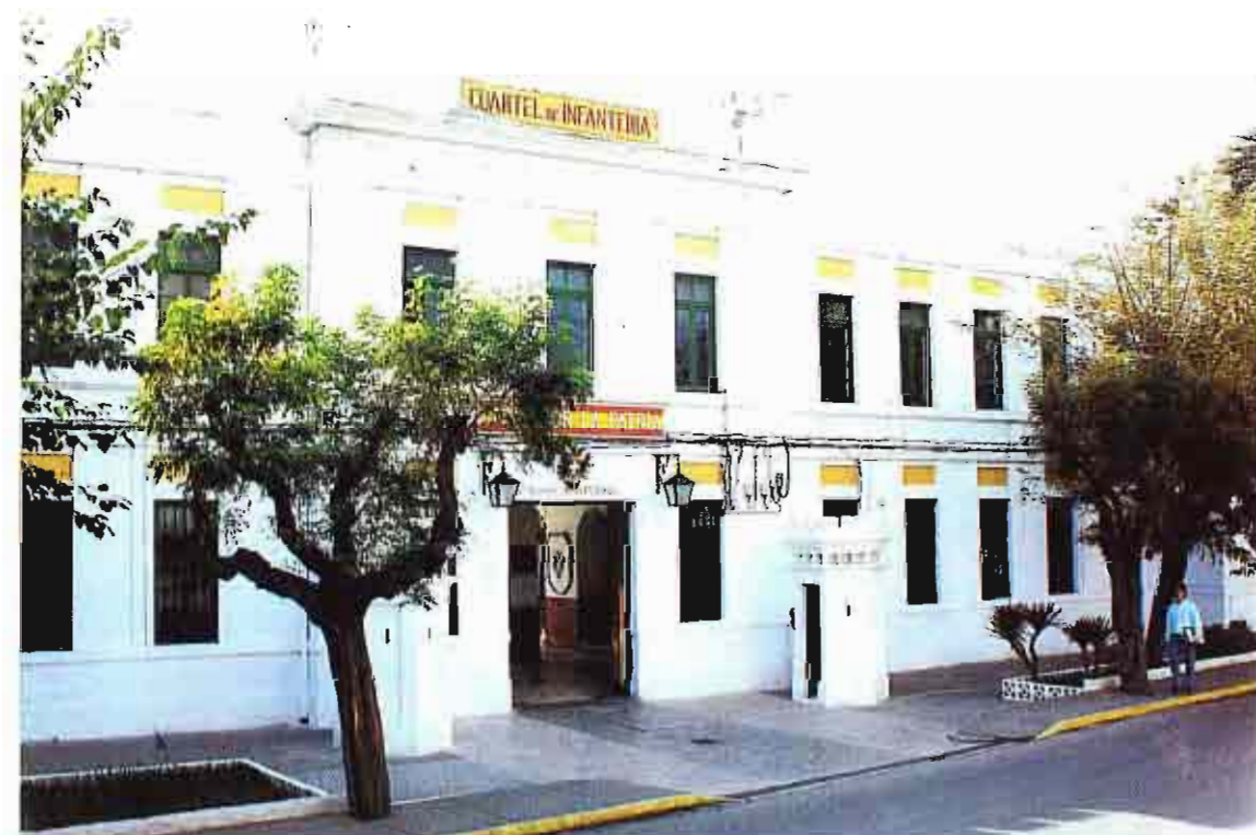
Acuartelamiento "General Ballesteros" (La Línea de la Concepción)
