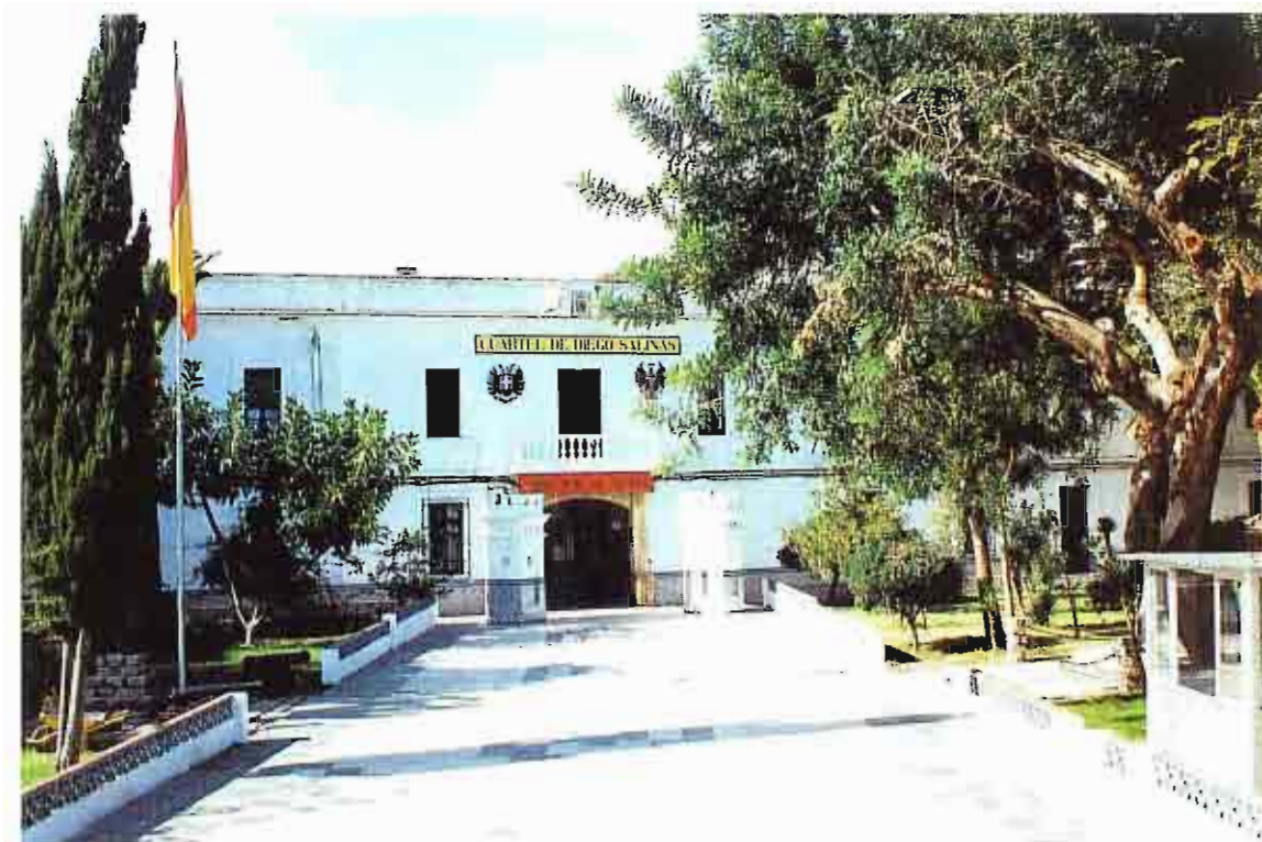
Acuartelamiento "Diego de Salinas" (San Roque)
