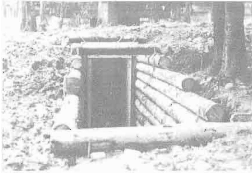
Fig. 9. Entrada al abrigo de pelotón, Abrigo de Pelotón, antes de recubrirlo ("Feldunterstand 88")
