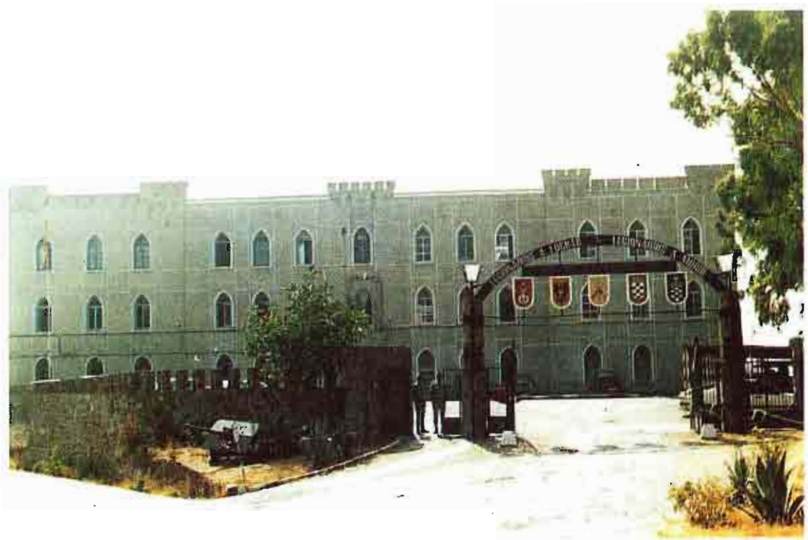
Acuartelamiento de "EL SERRALLO"
