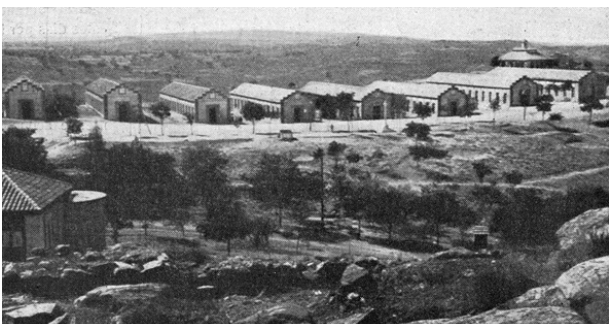
El Campamento en 1916 con sus ocho barracones ya construidos.
