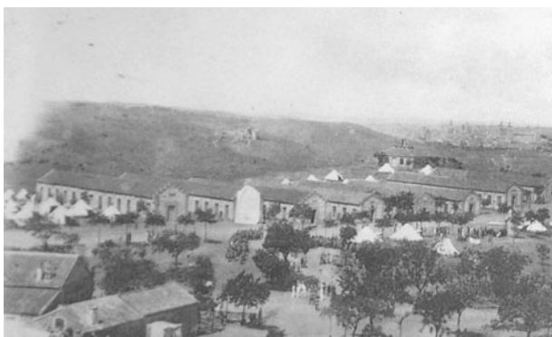
Vista del Campamento en 1921.
