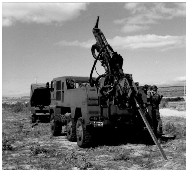
Figura 21.- Ahoyador en perforación
