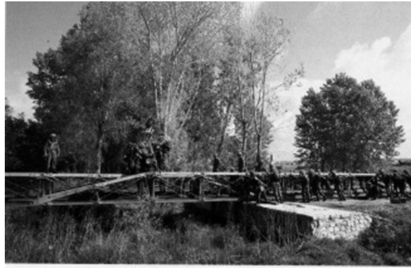
Figura 8.- Puente MAN ligero en montaje
