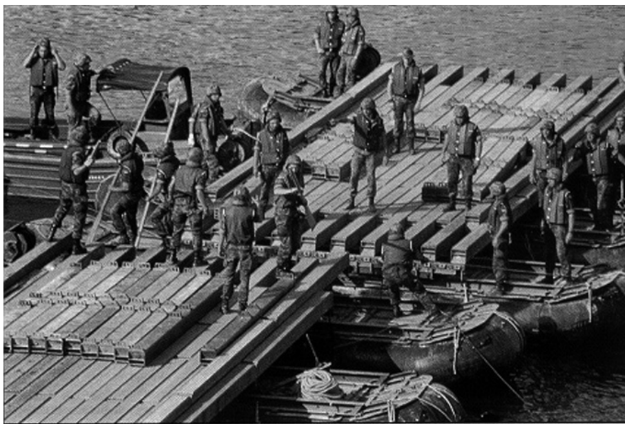
Figura 11.- Montaje de puente PF-50
