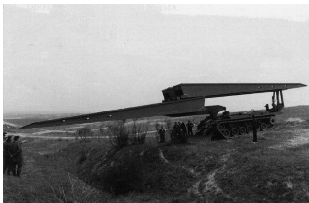
Figura 6.- VLP deslizante en lanzamiento
