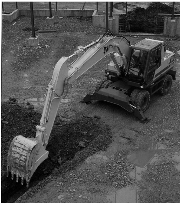
Figura 25.- Retroexcavadora de ruedas JCB JS150W
