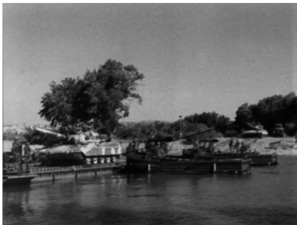
Figura 10.- Montaje de puente MAN de tablero flotante
