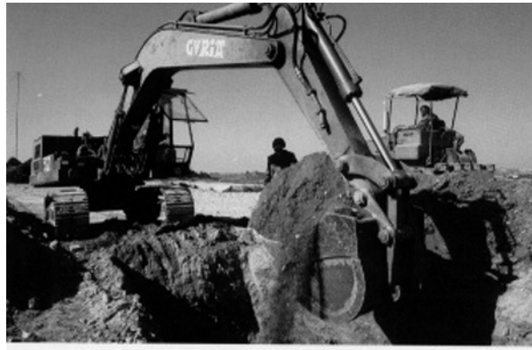
Figura 24.- Retroexcavadora de cadenas Guría 521
